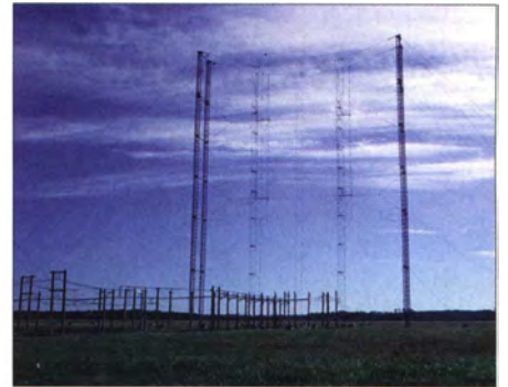
Bild 3: Die KW-Ausstrahlung erfolgt über eine solche Vorhangantenne der Sendestation Edward R. Murrow in den USA. Der verwendete 250-kW-AM-Sender ist 50 Jahre alt.
