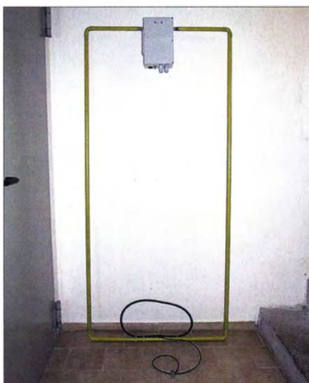
Bild 5: Gelöteter Rahmen in Rechteckform, mit Schutzanstrich versehen
