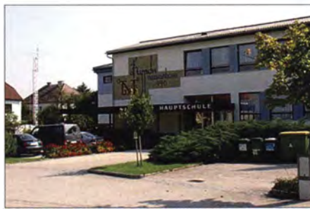
Das Schulzentrum in Neuhofen/Ybbs Foto:
